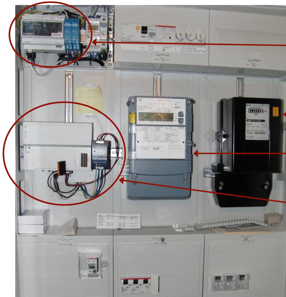
Kommunikationseinheit zur Übertragung von Signalen aus dem Ortsnetztrafo in das Wohngebäude
