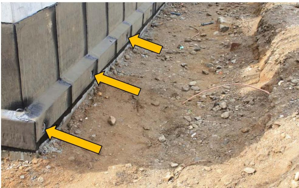
Abb. 3: Erdungsfestpunkte zur Anbindung des integrierten Potenzialausgleichssystems an das umliegende Erdungssystem
