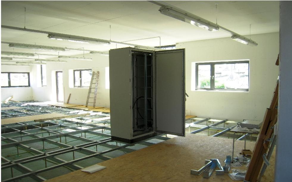
*Abb. 4: Errichtung eines Leittechnikraumes und Einbindung eines Schaltschranks in das Potenzialausgleichssystem*
