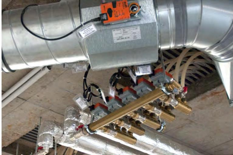
Durchflussmengenregelung für niedrige Pump- und Ventilatorleistungen
