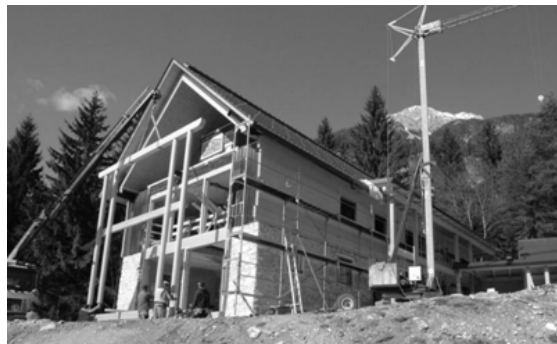
Abbildung 4: neuer Dachstuhl samt Vorbau
