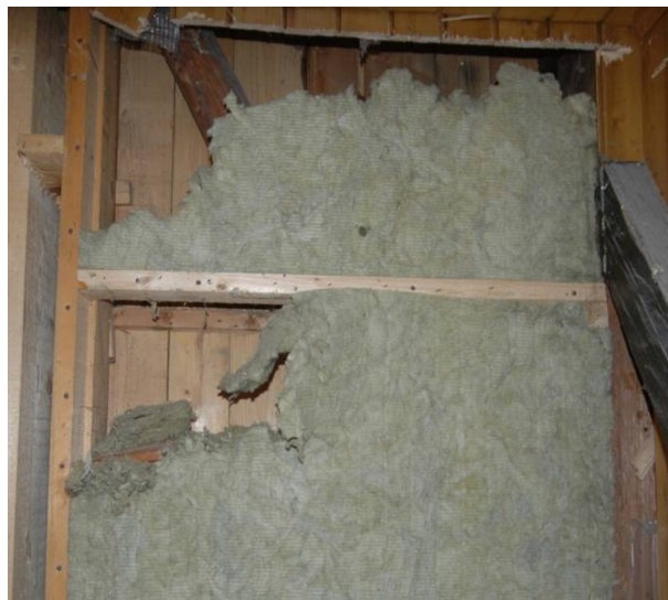
Abbildung 13: Nachdem vollflächigen Öffnen der bestehenden Holzriegelwände musste zur Kenntnis genommen werden, dass ein Mader oder Siebenschläfer über Jahre hinweg große Teile der Außendämmung vernichtet hat.
