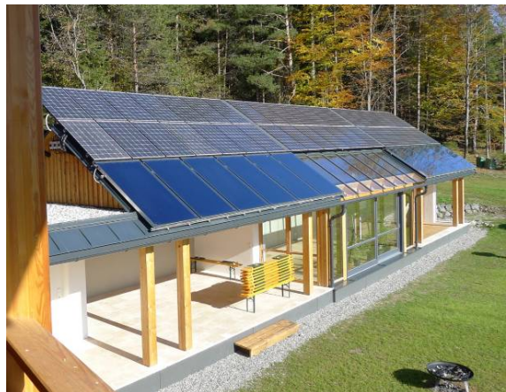
Abbildung 21: Glashaus mit Solarthermie und Photovoltaik
