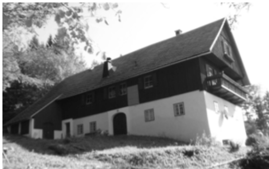
Abbildung 1: Altbestand vor Beginn der Baumaßnahmen
