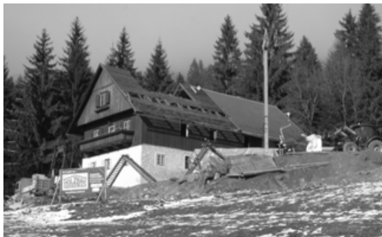
Abbildung 3: Abbruchsarbeiten des alten Dachstuhles
