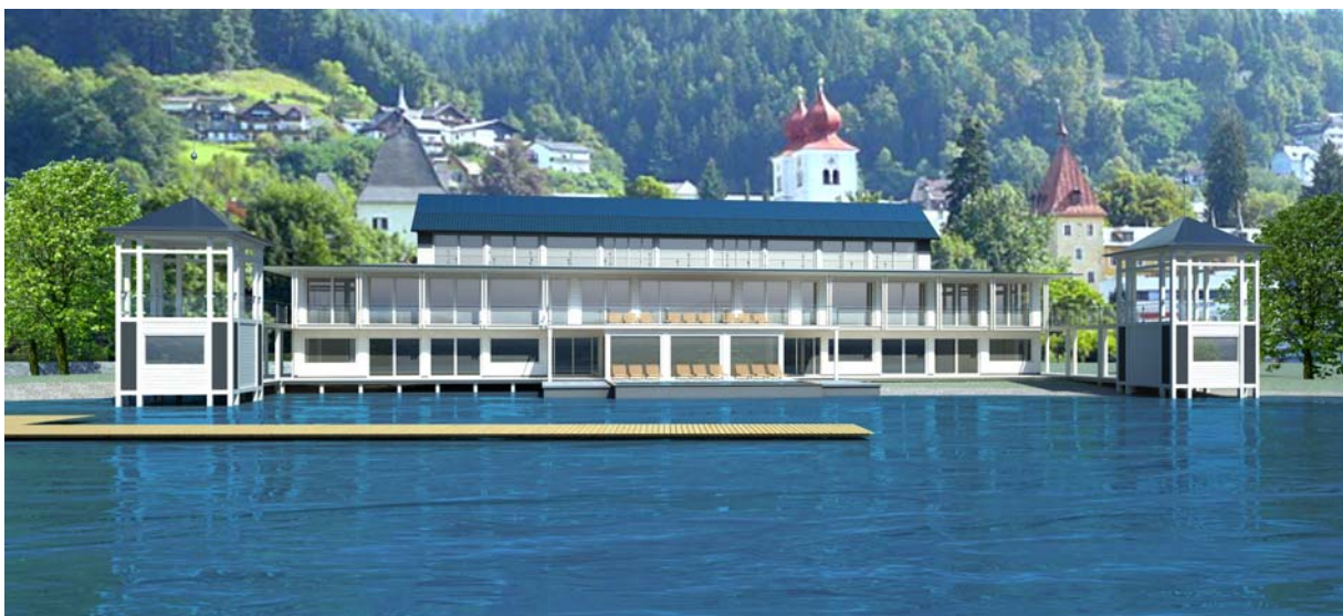
Abbildung 11 und 12: 3D-Darstellungen. Das „Kärntner Badehaus“ lehnt sich hinsichtlich seines Baukörpertypus an die ca. 100 Jahre alte Tradition der Kärntner See-Architektur an, ist aber hinsichtlich Funktionalität, Haustechnik und Gebäudehülle nach dem modernsten Stand eines Passivhauses konzipiert. Es wird in reiner Holzbauweise errichtet.
