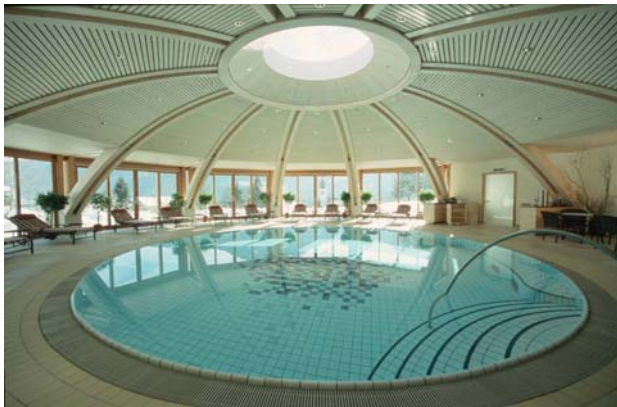
Abbildung 2: rundes Schwimmbaden im Biohotel DABERER, St. Daniel/Gailtal: Die polygonale Holzkuppel mit Gründach verfügt über ein optimales Oberflächen-Volumen-Verhältnis, Stahlbeton-Innenbecken mit hochgedämmten Beckenkörper zur Verringerung der Wärmeverluste, ausgeklügelte Lüftungsführung zwischen den Doppelwänden
