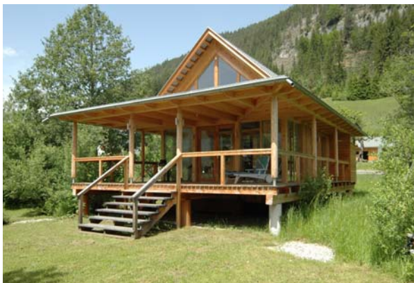
Abbildung 4: kleines BADE- UND SAUNAHAUS AM WEISSENSEE in reiner Holzkonstruktion und Passivhausbauweise errichtet. Südorientierung mit ausreichend solaren Gewinnen trotz weit ausladender Terrassenüberdachung
