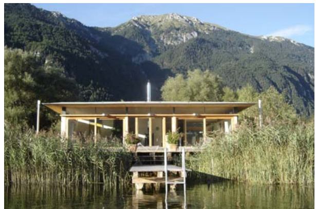
Abbildung 5: SCHWIMMENDES SAUNAHAUS AM PRESSEGGER SEE aus Holz mit 50 cm starken Styropor-Schwimmkörpern im Boden, welche gleichzeitig als Schwimmkörper und Außendämmung des Bodens dienen
