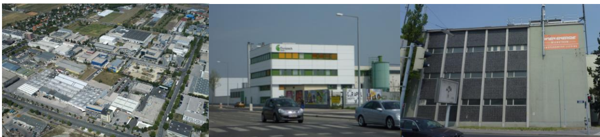
Abbildung 7: Im Industriegebiet befinden sich die größten Dachflächen Wiens; je nach Gebäude unterschiedliche Möglichkeiten zur dezentralen Energieerzeugung, (Bildquelle: MA 21B, New Energy)
