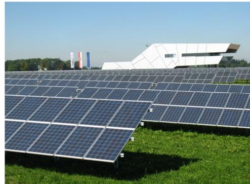
Modultechniken und Wechselrichterkonzepte werden zur Stromerzeugung parallel betrieben, neue Lösungsansätze werden im Betrieb des Kraftwerkes auf deren Praxistauglichkeit hin überprüft. Aufschlüsse erwarten wir uns zudem über die Einflüsse von Witterung, Komponententalterung, Lebensdauer und Leistungsänderung durch die natürliche Verschmutzung der Solarzellen [1].
