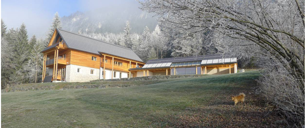
Gesamtanlage nach Fertigstellung im Oktober 2011 mit PV-Anlagen und Solarthermie
