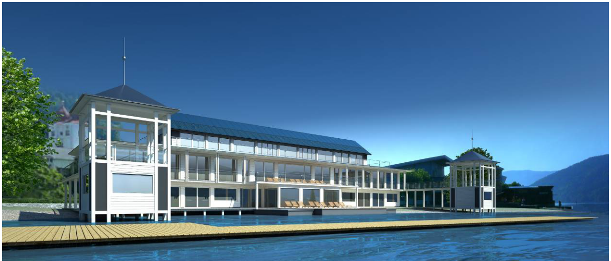
Das „Kärntner Badehaus“ lehnt sich zwar hinsichtlich seines Baukörperstypus an die ca. 100 Jahre alte Tradition der Kärntner See-Architektur an, ist aber hinsichtlich Funktionalität, Haustechnik und Gebäudehülle nach dem aktuellen Stand des Passivhauses konzipiert.
