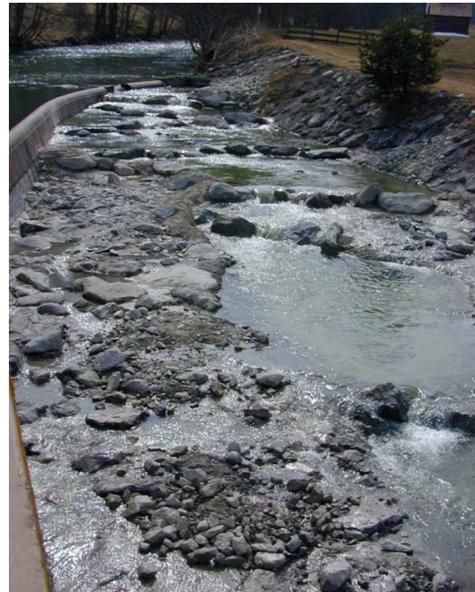
Nach dem Umbau
