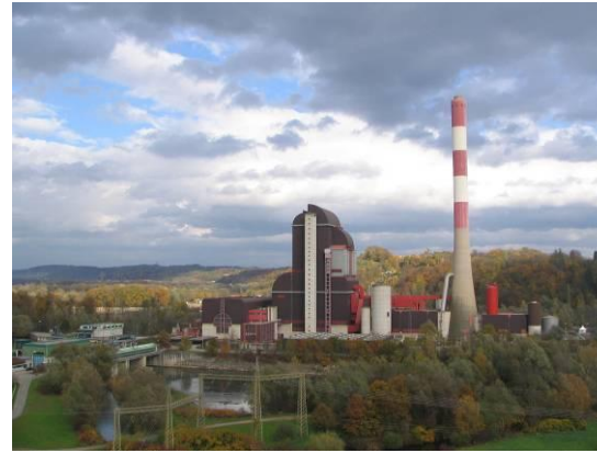
Mellach, 246 MW / SK
