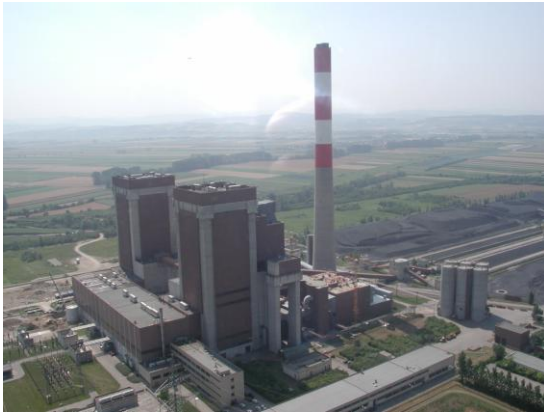
Dürnrrohr, 405 MW / SK
