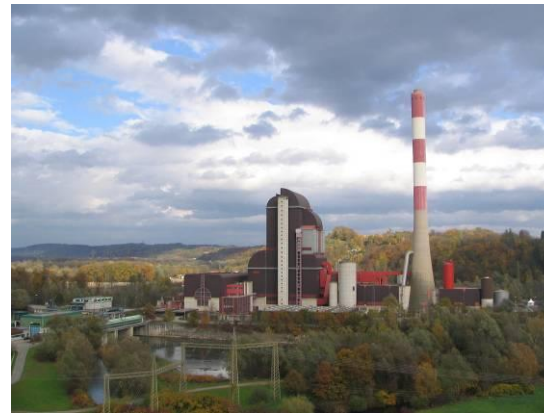
Mellach, 246 MW / SK
