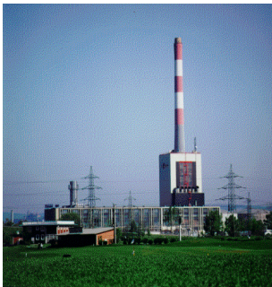
Korneuburg 285 MW Gas
