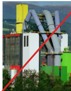
St. Andrä 124 MW SK
