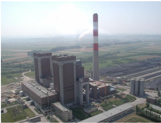
Dürnrrohr, 405 MW / SK
