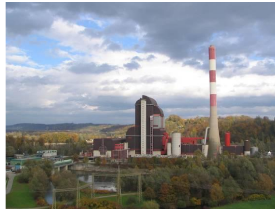
Mellach, 246 MW / SK
