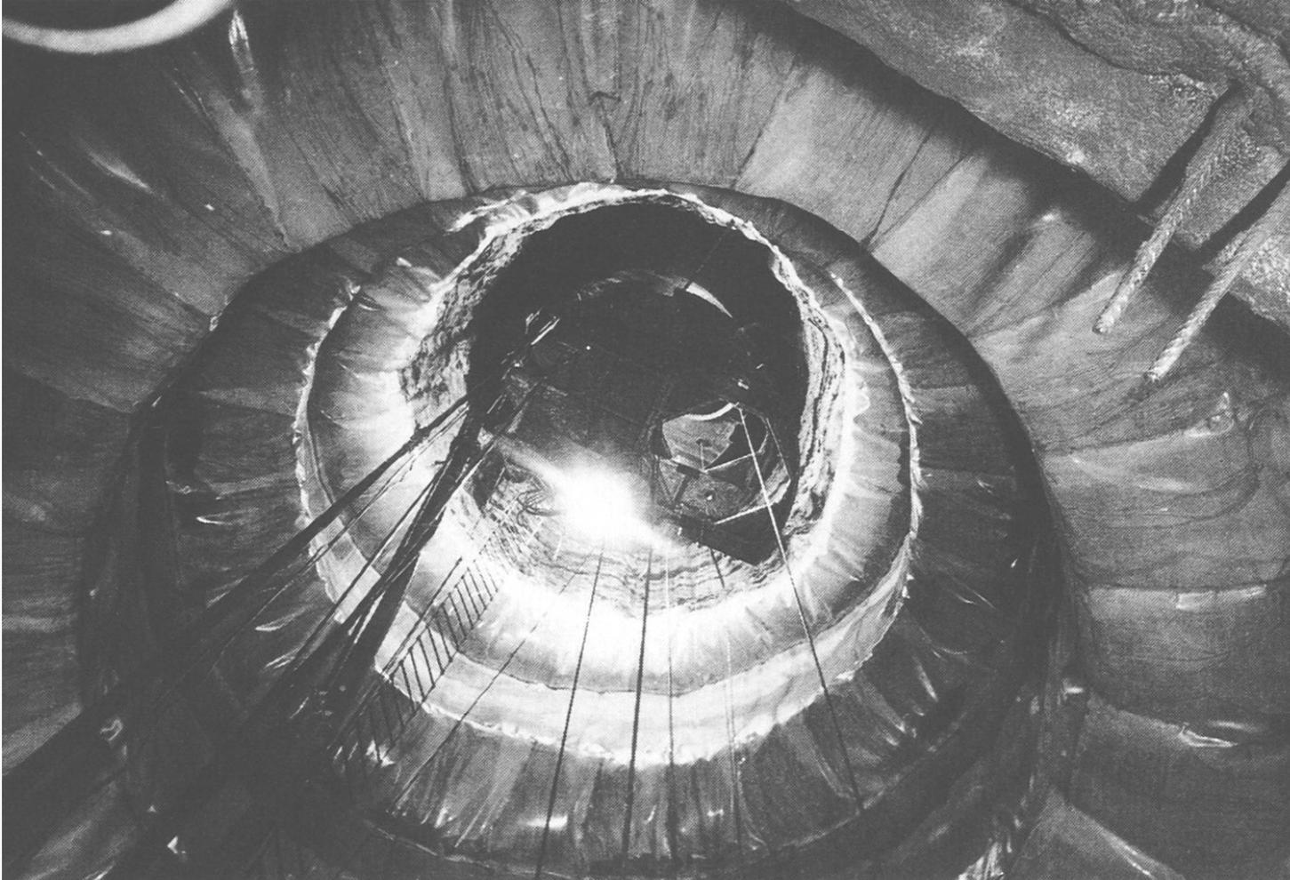
Anwendung einer speziellen Widerlagergeometrie sowie einer PVC-Folie zur Schonung der Gebirgskonturen
