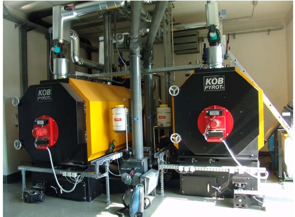
**Abb. 19** Biomassekessel-Kombination (540 kW + 390 kW)
