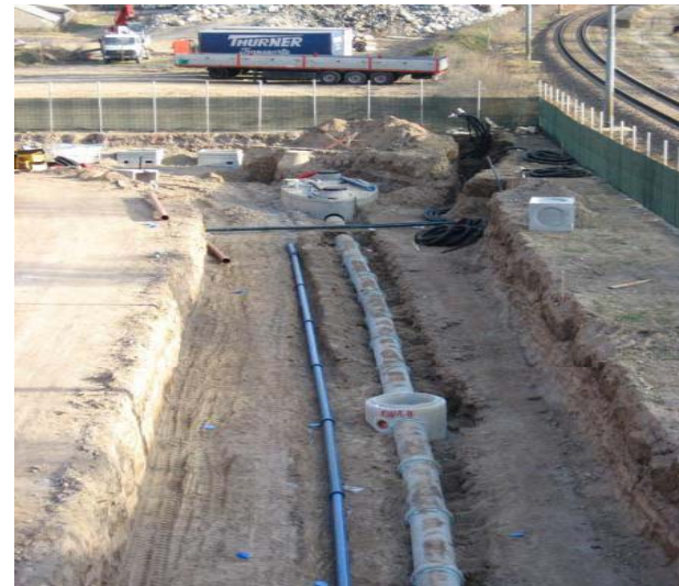
Verlegung einer Erdgasleitung
