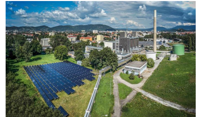
Quelle: S.O.L.I.D (AEVG-Fernheizwerk Graz)
