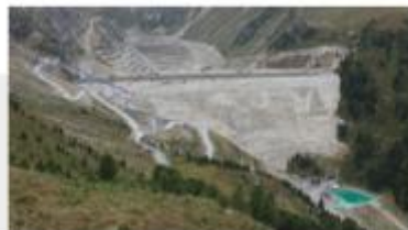
Kühltai TIWAG 130 MW-T / 140 MW-P In Bau; IBN: 2026
