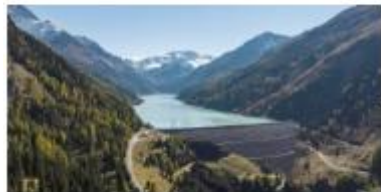
Kaunertal (Versetz/Prutz II) TIWAG 900 MW-T; 400 MW-P In Genehmigung; IBN: 2034
