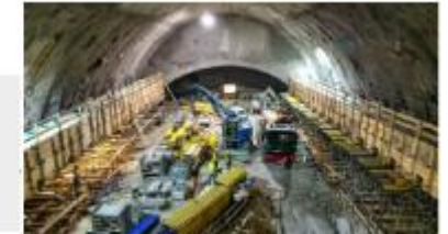
Ebensee Energie AG 170 MW-T; 150 MW-P In Bau; IBN: 2028
