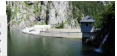
Salza VERBUND 480 MW T/P In Planung; IBN: 2036
