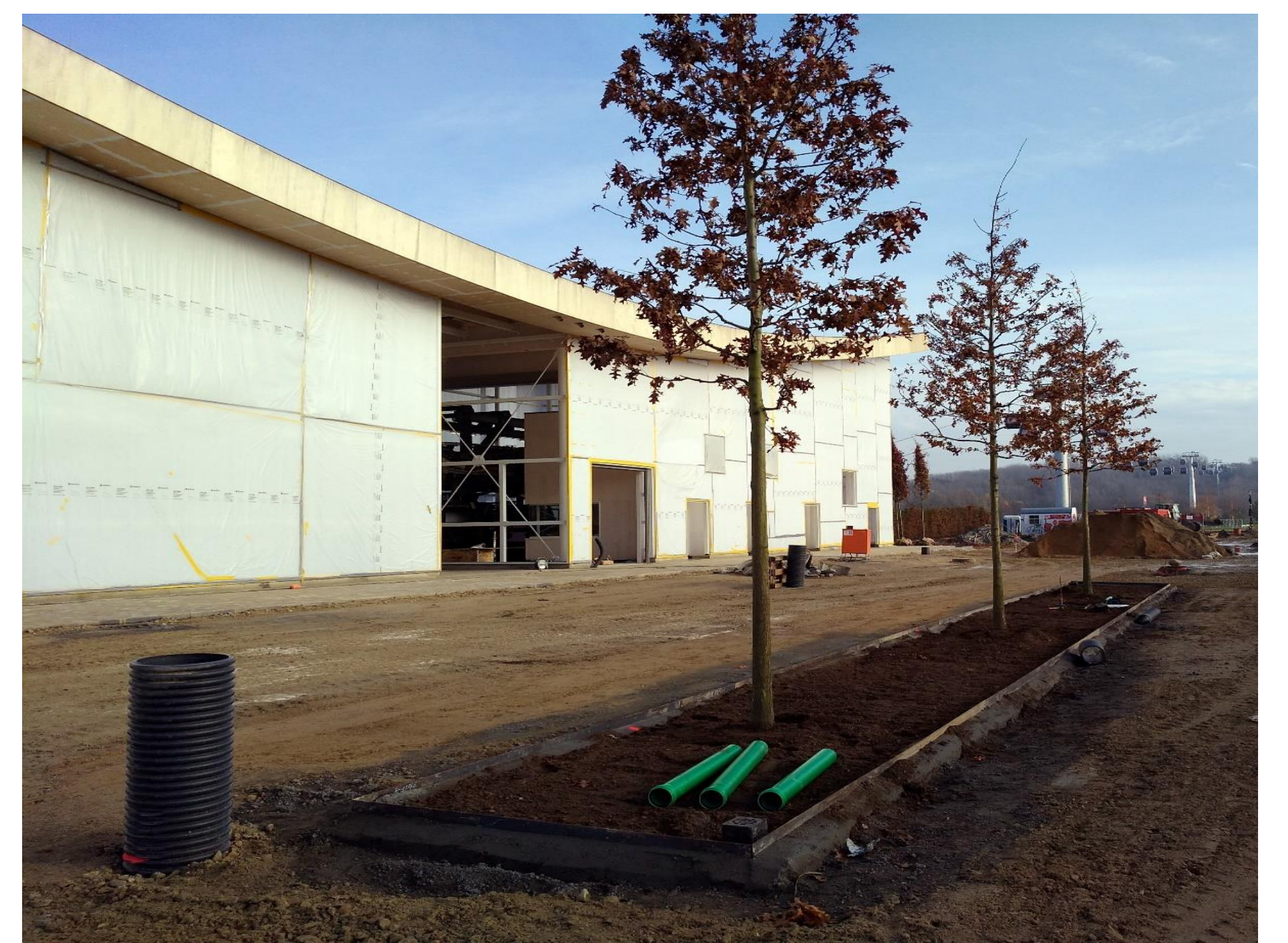
Baum-Rigole während der Bauphase
