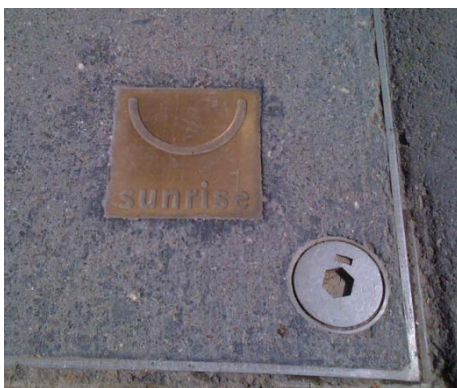
Abb. 5: Bsp. Messingplättchen in Betondeckel
