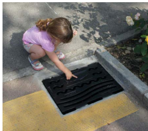
Abb. 10: FishRoll in Schacht eingebaut
