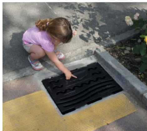
Abb. 10: FishRoll in Schacht eingebaut
