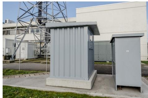
Abbildung 6: Linkes Bild: Relaisauswahlschrank, rechtes Bild: Relaisauswahlschaltung und KNOPE Widerstand (kleinerer Schrank)
